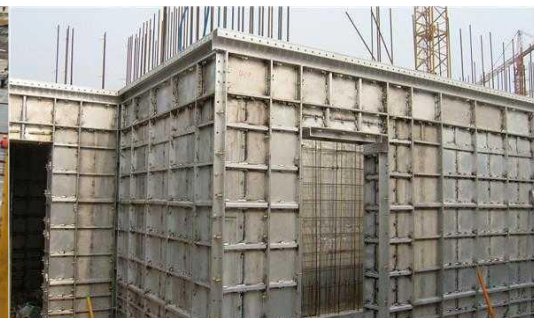
Fig.No.2. Mivan Formwork.
